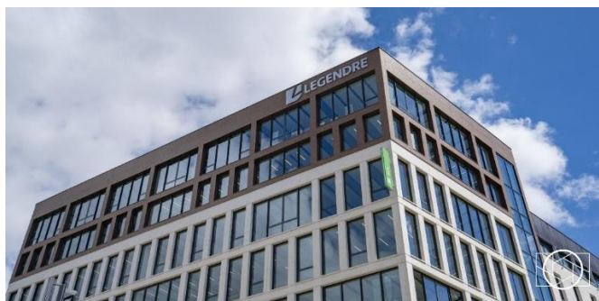
Bureaux de Legendre Construction en Ile-de-France situés au 155 boulevard Maxime Gorki à Villejuif (94). Agence d'architecture LANCUIT ARCHITECTE.
