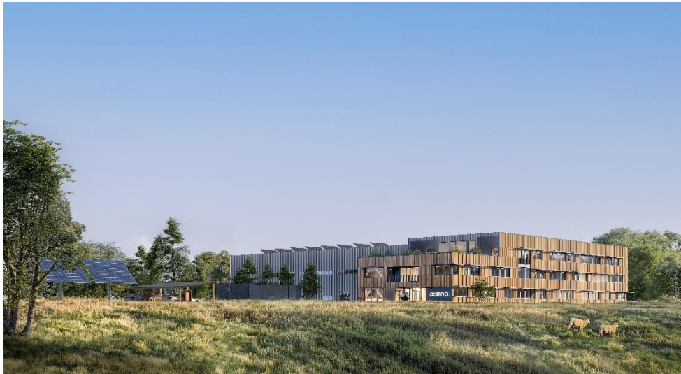
Futur siège social et site industriel OKWIND - ©Unité
